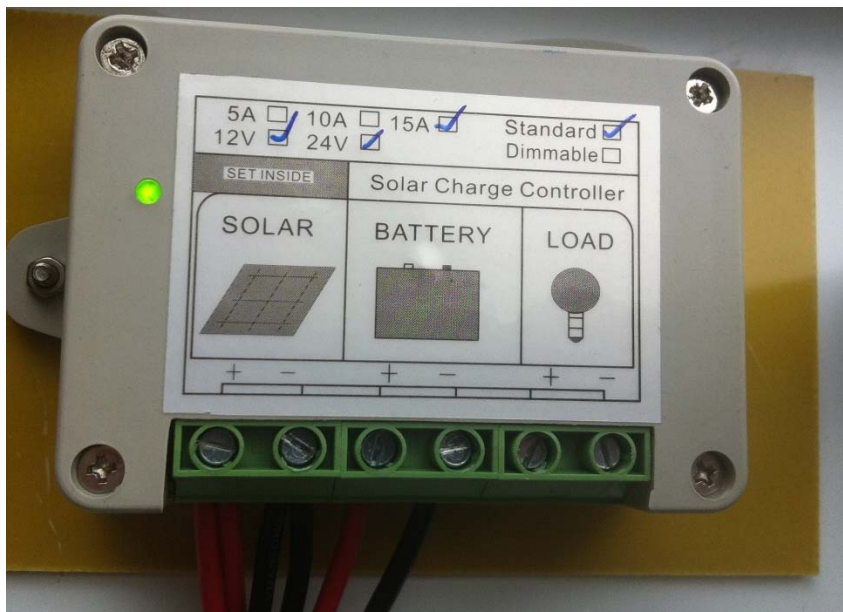
Obr.23:Nabíječ baterií 12V na FV panelu
