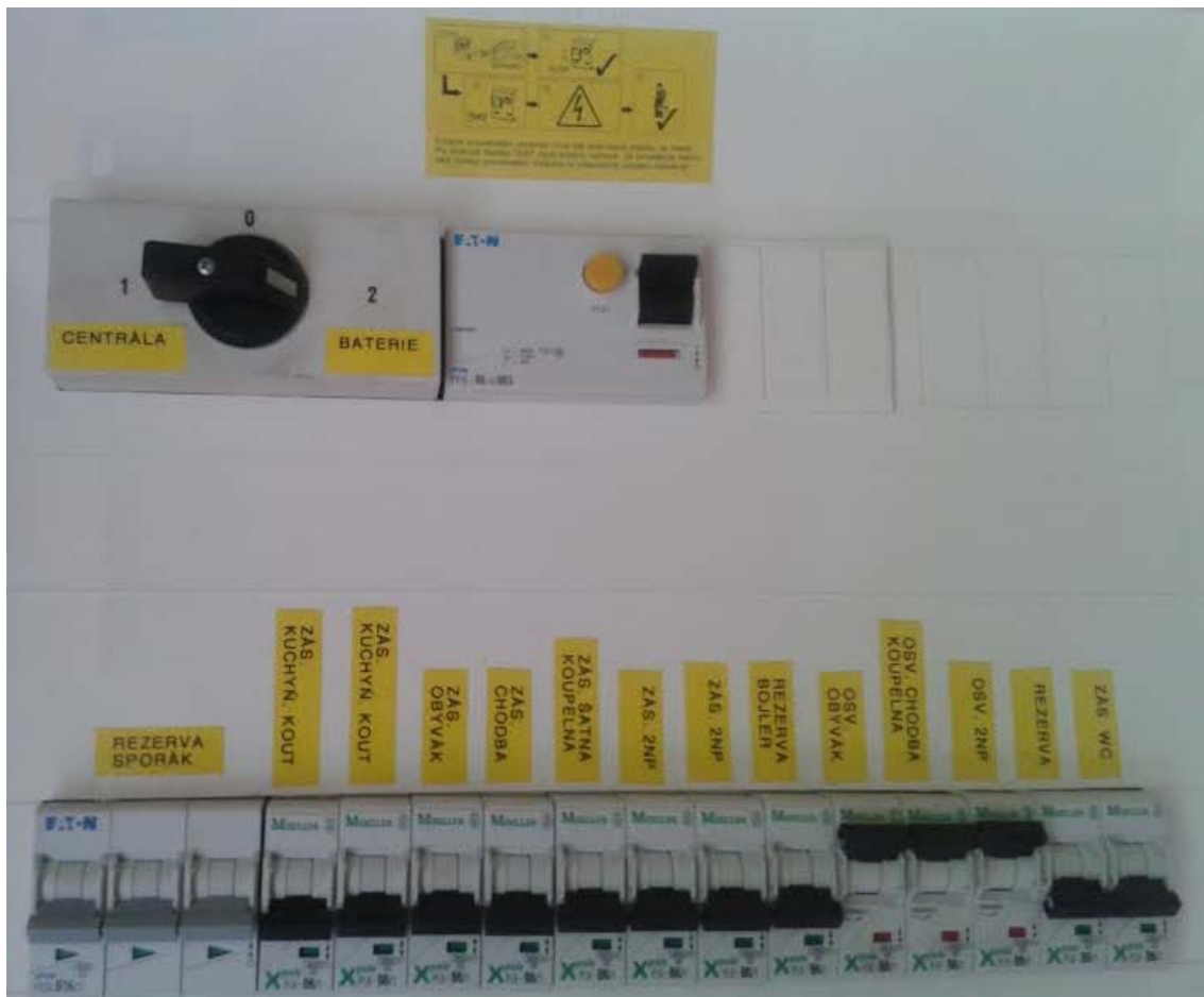
Obr.7:Domovní rozvodnice
